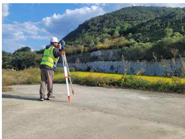
광파기를 이용한 측량 작업
