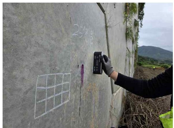
경사계를 이용한 경사도 측정
